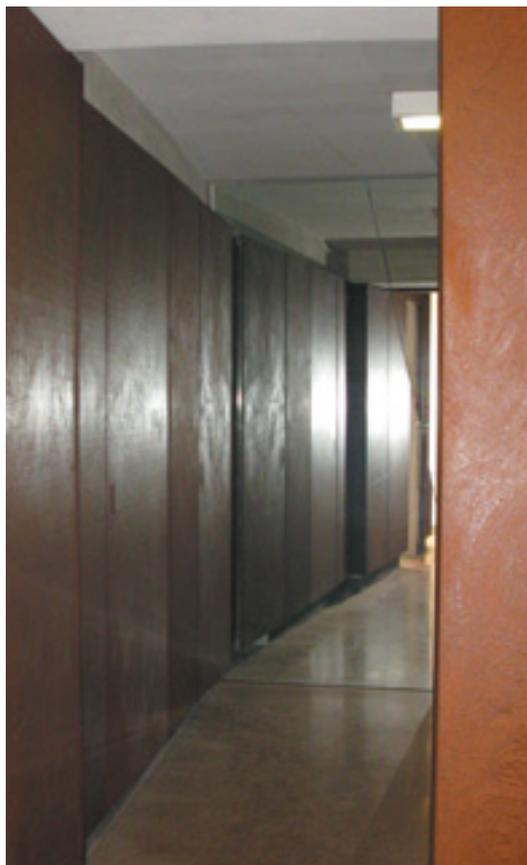
Fig. 10 - Piacenza, palazzo Chiapponi, androne di passaggio al terzo cortile con i pannelli di rivestimento parietale in acciaio corten
