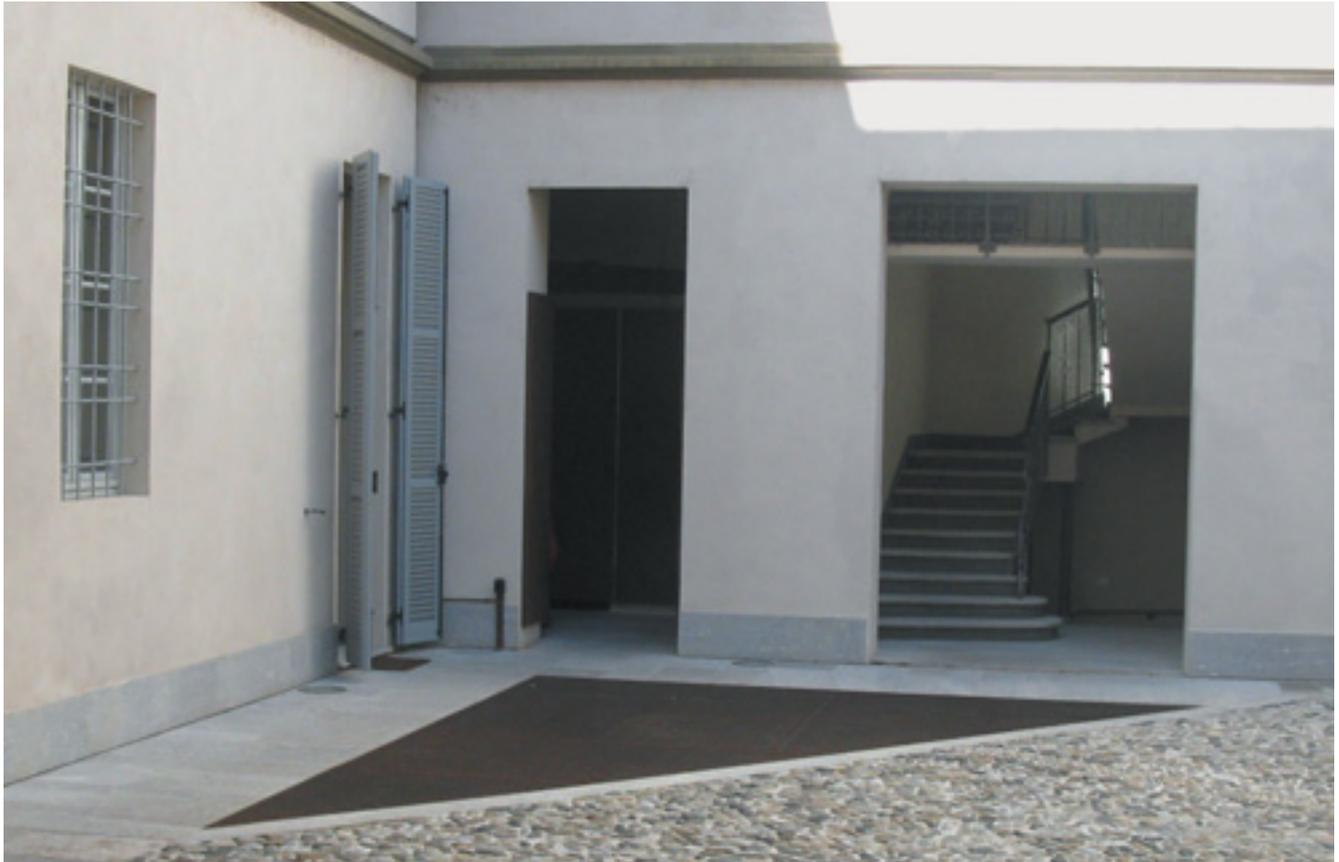
Fig. 9 - Piacenza, palazzo Chiapponi, cortile d'onore, particolare della pavimentazione con l'insero grigliato di forma triangolare in acciaio corten
