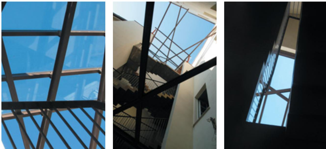
Figg. 15, 16, 17 - Piacenza, palazzo Chiapponi, terzo cortile, particolari della scala in acciaio corten e dell'orditura metallica della copertura
